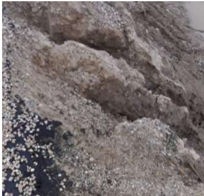
Figure 2 निर्माणधीन सडकको अवस्था
