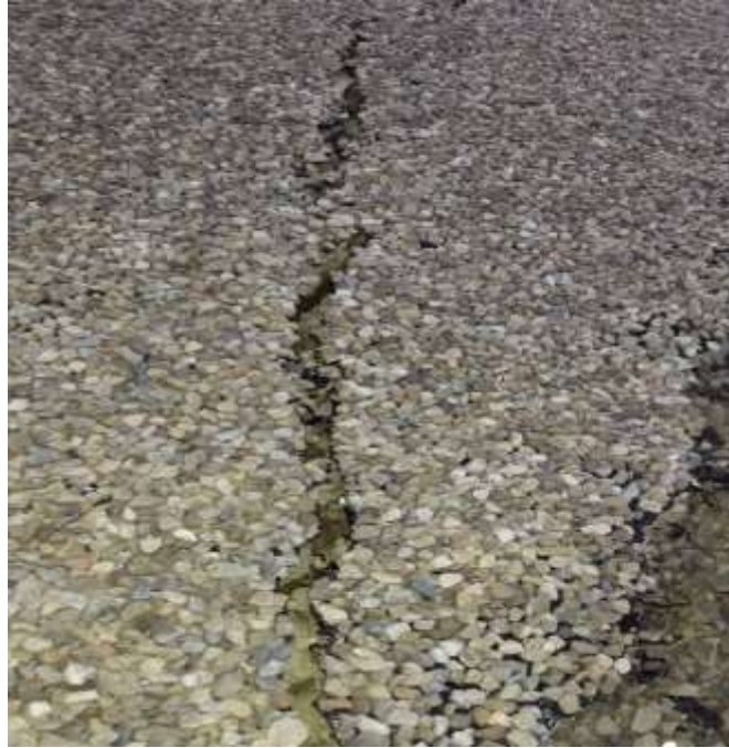
Figure 1 सडक निर्माणको अवस्था
