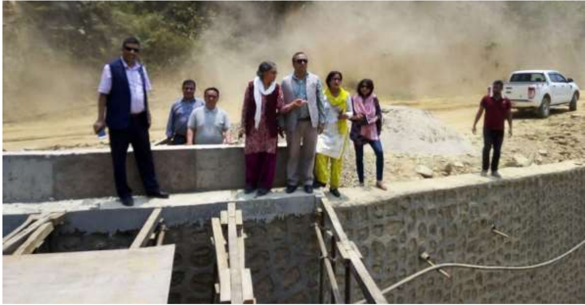
Figure 1 सिन्धुपाल्चोकमा निर्माणधिन पुलको अवलोकन गरिँदै ।
